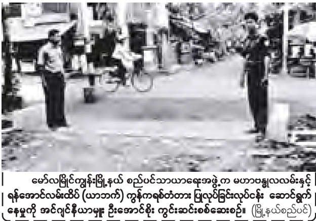
မော်လမြိုင်ကျွန်းမြို့နယ် စည်ပင်သာယာရေးအဖွဲ့က မဟာဗန္ဓုလလမ်းနှင့် ရန်အောင်လမ်းထိပ် (ယာဘက်) ကွန်ကရစ်တံတား ပြုလုပ်ခြင်းလုပ်ငန်း ဆောင်ရွက် နေမှုကို အင်ဂျင်နီယာမှူး ဦးအောင်စိုး ကွင်းဆင်းစစ်ဆေးစဉ်။ (မြို့နယ်စည်ပင်)
