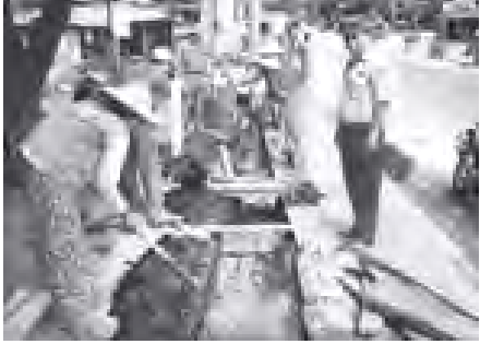
သာစည်မြို့နယ်စည်ပင်သာယာရေးအဖွဲ့ ဝန်ထမ်းများ မြို့ကျင်းရေခြောင်းများ ရေစီးရေလာတောင်းမှုနဲ့စေ့စေ့အတွက် အမှတ်(၅)ရပ်ကွက် လမ်းမတော်ဘေးတစ်လျှောက်ရှိ ရေခြောင်းများ ကူးစီးမြစ်လုပ်ငန်းကို ဇွန် ၁၅ ရက်တွင် ဆောင်ရွက်ရာ အမှုဆောင်အရာရှိ ဦးကျော်နိုင် ကွင်းဆင်းကြည့်ရှုဆောင်ရွက်စဉ်။ (မြို့နယ်စည်ပင်)
