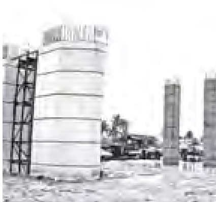
ဒုတိယသမ္မတ သီဟသူရဦးတင်အောင်မြင်ပြီး ဘိုကလေးမြစ်ကူးတံတား တည်ဆောက်နေမှုကို ကြည့်ရှုစစ်ဆေးစဉ်။ (သတင်းစုံ)
