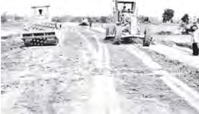
စင်းခန်း-ကသာ မော်တော်ကားလမ်းမောက်လုပ်ရာတွင် ဖို့မြေများ သိပ်သည်းမှုရရှိနေအတွက် မြေညှိ-မြေသိပ် ကြိတ်စက်ကြီးများဖြင့် ဤသို့ဆောင်ရွက်လျက်ရှိသည်။ (သတင်းစဉ်)
