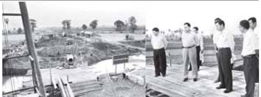
ရထားပို့ဆောင်ရေးဝန်ကြီးဌာန ပြည်ထောင်စုဝန်ကြီး ဦးအောင်မင်း တပ်ကုန်းမြို့နယ် ဗျိုင်းအင်းကျေးရွာအနီးရှိ နဝင်းချောင်း တံတား တည်ဆောက်နေမှုကို ကြည့်ရှုစစ်ဆေးစဉ်။ (သတင်းစဉ်)
