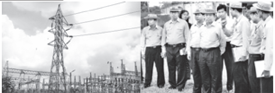
အမှတ်(၂) လျှပ်စစ်စွမ်းအားဝန်ကြီးဌာန ပြည်ထောင်စုဝန်ကြီး ဦးခင်မောင်စိုး ရန်ကုန်တောင်ပိုင်းခရိုင် ၂၃၀ ကေစီ လှော်ကား ပင်မဓာတ်အားခွဲရုံ Switch Yard အတွင်း၌ ၃၃ ကေစီ Out door Switch Bay ၁၇ ခု တည်ဆောက်နေမှုကို ကြည့်ရှုစစ်ဆေးစဉ်။ (သတင်းစဉ်)
