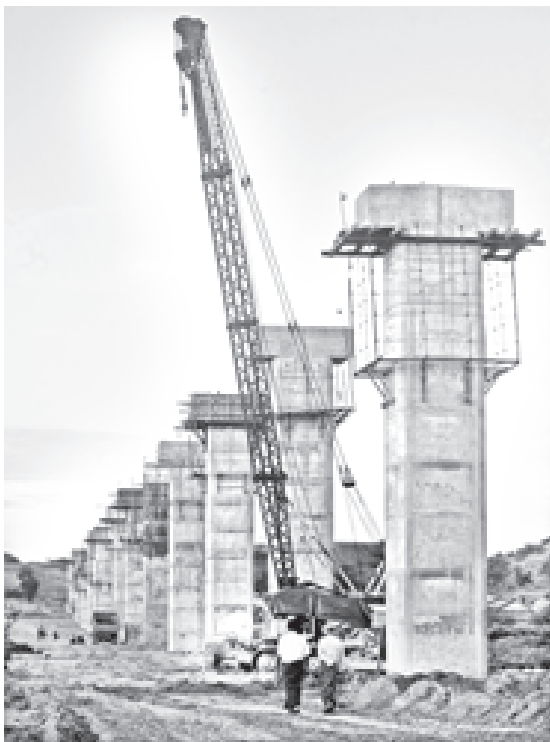
ရော့ဘတ်တံတား(မလွန်)၏ ချဲ့တင်တံတားတိုင်များ တည်ဆောက်နေမှုကို ၂၀၁၀ ခုနှစ် နိုဝင်ဘာ ၁ ရက်က ဤသို့တွေ့ရစေ။
