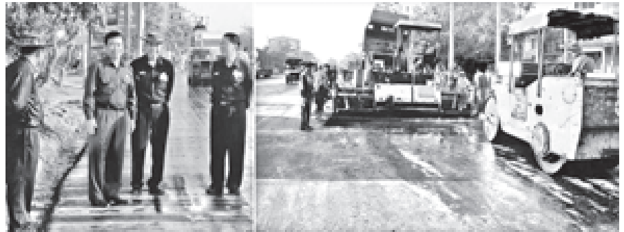
ရန်ကုန်မြို့တော်ဝန် ဦးလှမြင့် ဘုရင့်နောင်လမ်း ကမ္ဘာ့ကုန်ကရစ် ထပ်ပိုးခင်းနေမှုကို ကြည့်ရှုစစ်ဆေးစဉ်။
