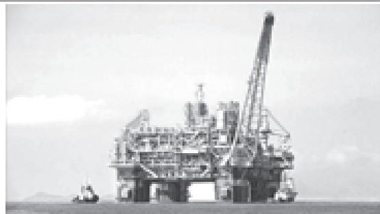
ဘရာဇီးပင်လယ်ကမ်းရိုးတန်းကမ်းလွန်၌ တည်ဆောက်ထားသည့် ရေနံတူးစင် ကို တွေ့ရစဉ်။ (ဓာတ်ပုံ-အင်တာနက်)
