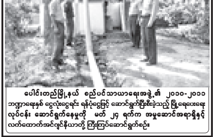
ပေါင်းတည်မြို့နယ် စည်ပင်သာယာရေးအဖွဲ့၏ ၂၀၁၀-၂၀၁၁ ဘဏ္ဍာရေးနှစ် ငွေလုံးငွေရင်း ရန်ပုံငွေဖြင့် ဆောင်ရွက်ပြီးသည့် ငွေရေပေးလုပ်ငန်း ဆောင်ရွက်နေမှုကို မတ် ၂၄ ရက်က အမှုဆောင်အရာရှိနှင့် လက်ထောက်အင်ဂျင်နီယာတို့ ကြိုကြိုဆောင်ရွက်စဉ်။
