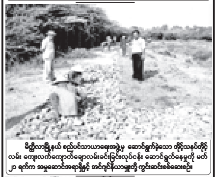
မိတ္ထီလာမြို့နယ် စည်ပင်သာယာရေးအဖွဲ့မှ ဆောင်ရွက်ခဲ့သော တိုင်းသမဂ္ဂတိုင်းလမ်း ကျေးလက်ကျောက်ချောလမ်းခင်းခြင်းလုပ်ငန်း ဆောင်ရွက်နေမှုကို မတ် ၂၀ ရက်က အမှုဆောင်အရာရှိနှင့် အင်ဂျင်နီယာတို့ တွင်းသစ်ဆေးစစ်ခဲ့။
