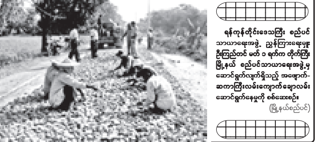
ရန်ကုန်တိုင်းဒေသကြီး စည်ပင်သာယာရေးအဖွဲ့ ညွှန်ကြားရေးမှူး ဦးကြည်တင် မတ် ၁ ရက်က တိုက်ကြီးမြို့နယ် စည်ပင်သာယာရေးအဖွဲ့မှ ဆောင်ရွက်လျက်ရှိသည့် အမှောက်-ဆက်ကြီးလမ်းကျောက်ချောလမ်း ဆောင်ရွက်နေမှုကို စစ်ဆေးပေး (မြို့နယ်စည်ပင်)
