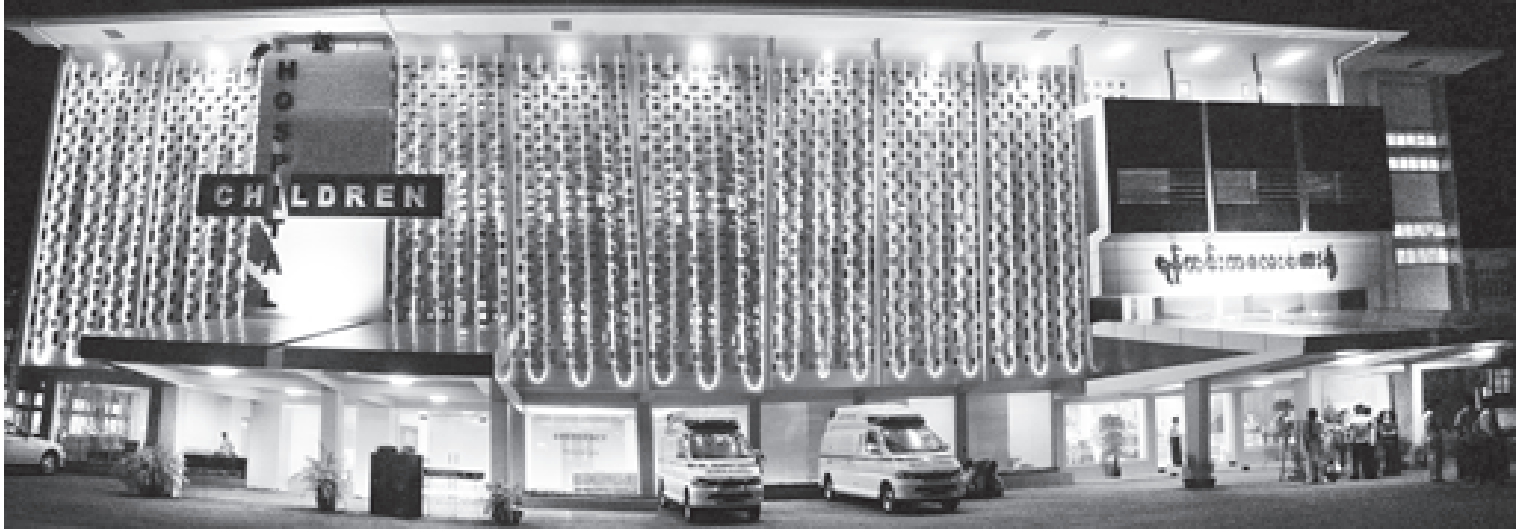
မက်စ်မြန်မာကုမ္ပဏီမီဒီယာစုက ပြုပြင်မွမ်းမံဆောက်လုပ်လျှင်သော ခုတင် (၅၅၀) ဆံ့ ရန်ကုန် ကလေးဆေးရုံသစ်ကြီးကို တွေ့ရစဉ်။ (သတင်းစဉ်)
