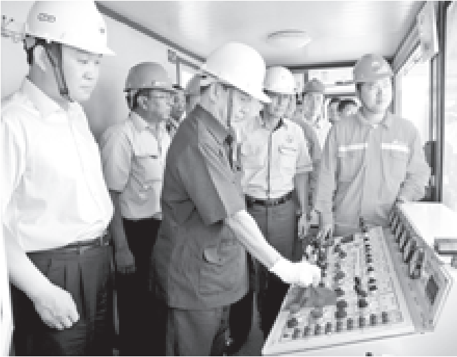
ရှမ်းအင်ဝန်ကြီးဌာန ဝန်ကြီး ဦးလွန်းသိ မြန်မာ-တရုတ် ရေနံစီမံခန့်ခွဲရေး သဘာဝဓာတ်ငွေ့ ပိုက်လိုင်းစီမံကိန်း ရေဝင်တံမြစ်ပြတ်ပိုက်လိုင်းအတွက် မြစ်ကြမ်းပြင်ဖောက်မှ Horizontal Directional Drilling Machine မြင့် စတင်တူးဖောက်ပွဲ အခမ်းအနားတွင် စက်လုပ်ကိုင်၍ စတင်တူးဖောက် ပွဲလုပ်ပေးသည်။ (သတင်းစဉ်)
