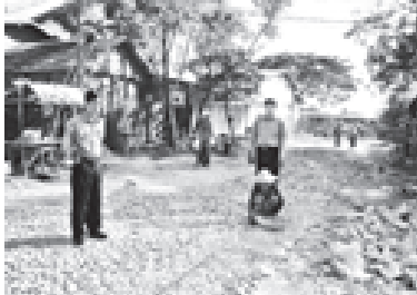
ပေမော်ဝါရီ ၁၅ ရက်က မတ္တရာမြို့နယ် စည်ပင်သာယာရေး အဖွဲ့မှ အမှတ်(၂) ဗြိသိပ်ရပ်ကွက် ရွှေဘိုလမ်း ကတ္တရာခင်းခြင်း လုပ်ငန်းဆောင်ရွက်နေမှုကို ဗြိနယ် စည်ပင်သာယာရေးအဖွဲ့ အမှုဆောင်အရာရှိ (လက်ထောက်ညွှန်ကြားရေးမှူး) ဦးမြင့်အောင်နှင့် လက်ထောက်အင်စုင်နာ ဦးဇော်မြင့်တို့ ကြည့်ရှုစစ်ဆေးခဲ့ကြောင်း (ဗြိနယ်စည်ပင်)
