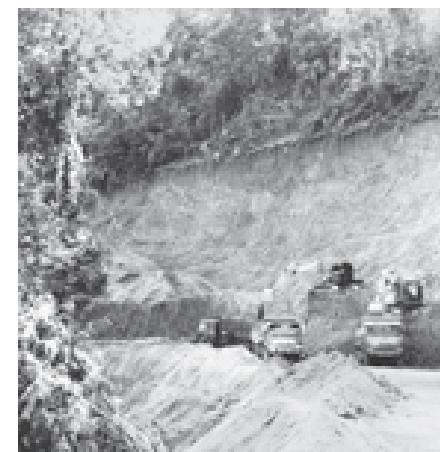
ပျဉ်းမနား-ပင်လောင်းလမ်း အကျယ်ချဲ့ခြင်းလုပ်ငန်းကို စက်ယန္တရားကြီးများဖြင့် ဤသို့ ဆောင်ရွက်နေစဉ်။
