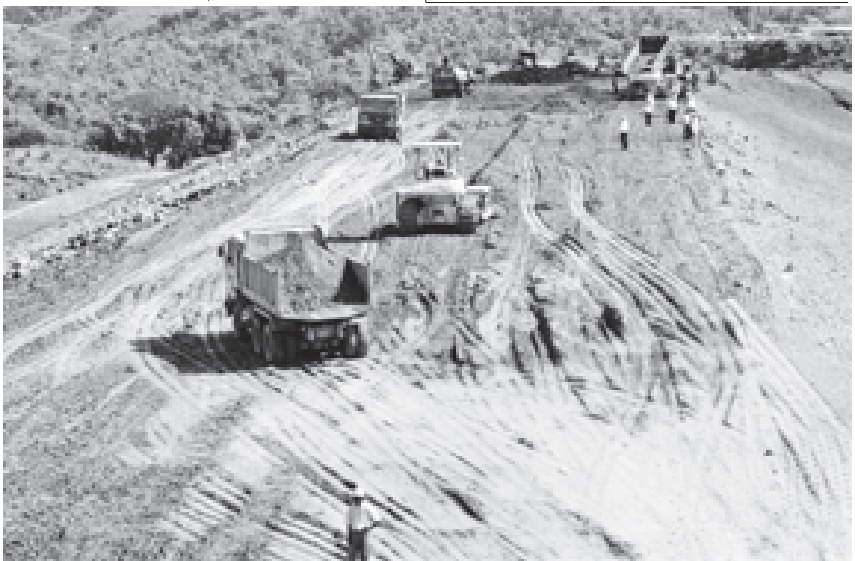
ကညင်ရေလျှော်တံဆံတွင် စက်ယန္တရားများဖြင့် မြေကြီးလုပ်ငန်းဆောင်ရွက်နေပုံ
