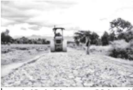
ရည်သင်းမြို့နယ် စည်ပင်သာယာရေးအဖွဲ့မှ မြို့ပြနှင့် ကျေးလက် အချိုးညီ တိုးတက်စေရန်အတွက် ရွှေဝါး-ကန်အောက်ကျေးလက်လမ်း ကျောက် နှောခင်းခြင်းလုပ်ငန်းကို ဒေါ်ကြည်ကြည်ဌေး (အလင်းတန်းအင်ဂျင် နီယာ-၂) အနီးကပ်ကြည့်ရှုဆောင်ရွက်စဉ်။ (မြို့နယ်စည်ပင်)
