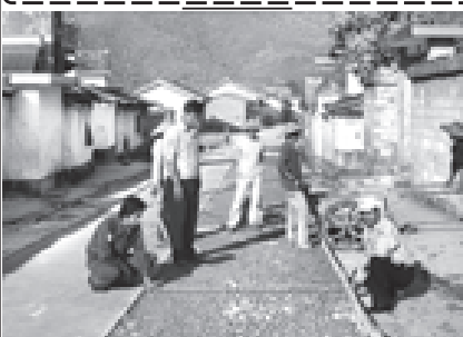
မိုးတုံမြို့နယ် စည်ပင်သာယာရေးအဖွဲ့က ဆောင်ရွက်လျက်ရှိသော ဇီဝဝါလမ်း ကွန်ကရစ်ခင်းခြင်းလုပ်ငန်းကို မေမော်ဝါရီ ၃ ရက်က မြို့နယ်တာဝန်ခံ ဦးအောင်လွင်ဦးနှင့် တာဝန်ခံအင်ဂျင်နီယာ ဦးစွန်းမြင့်အောင်တို့ ကြီးကြပ် ဆောင်ရွက်စဉ်။ (မြို့နယ်စည်ပင်)
