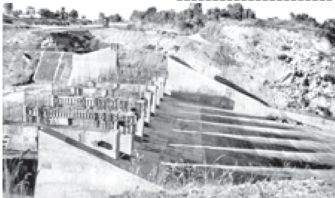
ကြီးအုံကြီးဝရေလှောင်တံမံ၏ ရေပိုလွှဲတည်ဆောက်ပြီးစီးမှု အခြေအနေကို တွေ့ရစဉ်။
