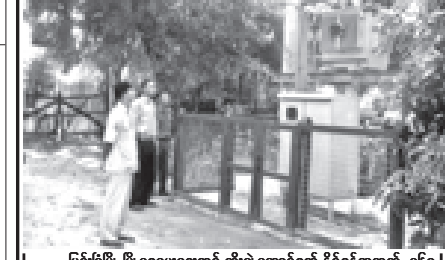
မြင်းမြို့မြို့နယ်ရေပေးစနစ်တွင် တူးချဆောင်ရွက် နိုင်ရန်အတွက် ၁၆၀ KVA ထရပ်စပေါ်မာ တပ်ဆင်ခြင်းကို ဒီဇင်ဘာ ၁၃ရက်က အမှုဆောင်အရာရှိ (ဒုတိယညွှန်ကြားရေးမှူး) ဦးအောင်ဌေးကြည် ကြီးကြပ်ဆောင်ရွက်စဉ်။ (မြို့နယ်စည်ပင်)
