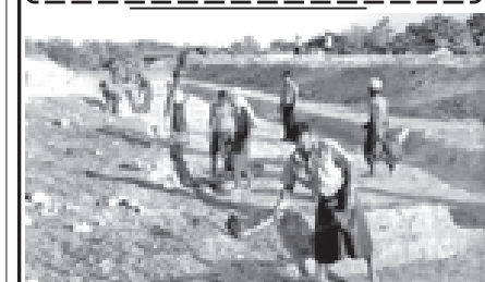
ပုဏ္ဏားကျွန်းမြို့နယ် စည်ပင်သာယာရေးအဖွဲ့၊ တန်ခိုးကျေးရွာ၌ မြေသားစိုးရေလောင်ကန်တူးဖော်ခြင်းလုပ်ငန်း ဆောင်ရွက်နေမှုကို တာဝန်ခံ အင်ဂျင်နီယာ ဦးကျော်မျိုးဌေး ကြီးကြပ်ဆောင်ရွက်စဉ်။ (မြို့နယ်စည်ပင်)
