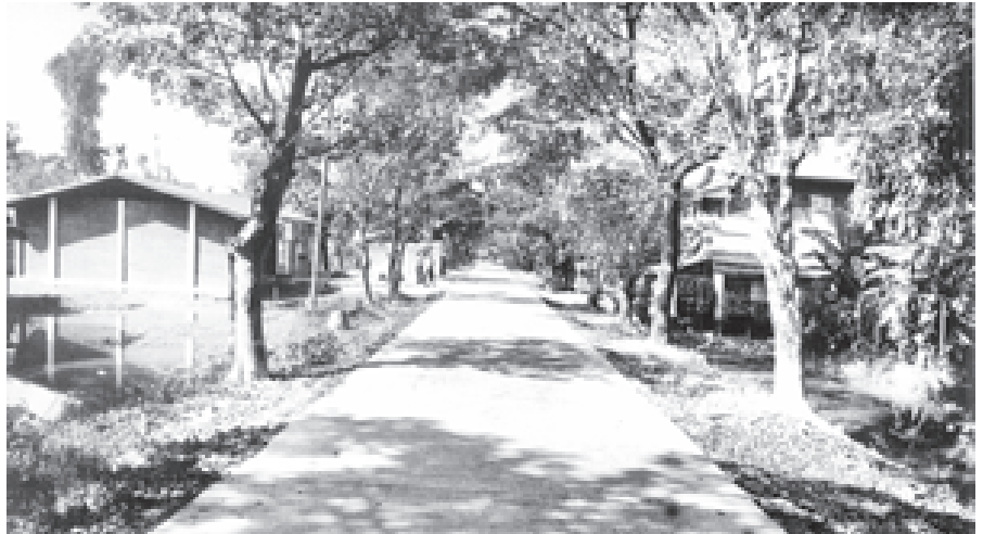
ဒေသပြည် ဘုရင့်နောင်ရပ်ကွက်၊ တပင်ရွှေထီးရပ်ကွက်နှင့် ကျန်စစ်သားရပ်ကွက်တို့ကို ဆက်သွယ်ပေးသည့် ပေ ၇၀၀၀ ရှိ ဆင်ဖြူရှင် ကွန်ကရစ်လမ်းသစ်အား တွေ့ရစဉ်။
