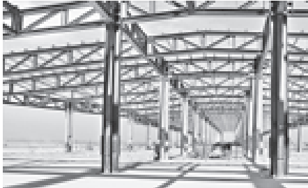
နေမှုနှင့်ပြီးစီးမှု၊ ပင်မအဆောက်အအုံအတွင်း ကြမ်းခင်းကျောက်ပြားခင်းရန် ရေတား ဌာနများ ဆောင်ရွက်နေမှုနှင့် လေဆိပ်ချွင်းကပ်လမ်း တည်ဆောက်ပြီးစီးမှု အခြေအနေ များကို ကြည့်ရှုစစ်ဆေးသည်။
