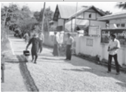
မင်းတင်မြို့နယ် စည်ပင်သာယာရေးအဖွဲ့က စာတိုက်လမ်း ကမ္ဘာ့ ဘဏ်လွှာခင်းနေမှုကို ဖြိုဖျက်ပစ္စည်း ဦးတိုက်လက်၊ အမှုဆောင်အရာရှိ ဦးကျော်တင်မောင်မောင်တို့ ကွင်းဆင်းစစ်ဆေးစဉ်၊ (မြို့နယ်စည်ပင်)
