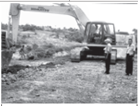
ရည်သင်းမြို့နယ် စည်ပင်သာယာရေးအဖွဲ့မှ ဝန်ထမ်းများ မတိုးကုန်း-ကုန်းသာမြို့သားလမ်းဖောက်လုပ်နေမှုကို လက်ထောက်အင်ဂျင်နီယာ ဦးအောင်မြင့် ကြီးကြပ်ဆောင်ရွက်စဉ်။ (သတင်းစဉ်)
