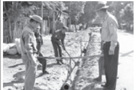
ရမည်းသင်းမြို့နယ် စည်ပင်သာယာရေးအဖွဲ့၊ ဝန်ထမ်းများ ရမည်းသင်းမြို့၊ သောက်သုံးရေ ကောင်းမွန်စွာရရှိရေးအတွက် အောင်မင်္ဂလာရပ်ကွက်ရှိ ရေပိုက်လိုင်းများ စစ်ဆေးပြုပြင်ခြင်းလုပ်ငန်းကို အမှုဆောင်အရာရှိ ဒုတိယ ညွှန်ကြားရေးမှူး ဦးသိန်းနိုင် ကင်းဆင်းစစ်ဆေးစဉ်။ (သတင်းစဉ်)
