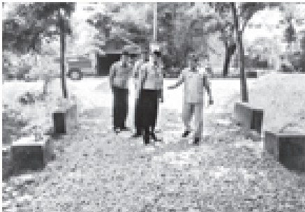
ရန်ကုန်တိုင်းဒေသကြီး စည်ပင်သာယာရေးအဖွဲ့ ညွှန်ကြားရေးမှူး ဦးအောင်ကျော်ဦး တန်းတပ်မြို့နယ် စည်ပင်သာယာရေးအဖွဲ့က ဆောင်ရွက် လျက်ရှိသော အထကလမ်း တက္ကရာဇ်ခင်းခြင်းလုပ်ငန်းကို ကျင်းဆင်းစစ်ဆေးရာ အမှုဆောင်အရာရှိ ဦးဆန်းအောင်နှင့် တာဝန်ခံအရာရှိဦးဖာ ဦးမျိုးမင်းတို့ ရင်းလင်းတင်ပြနေပုံ။
