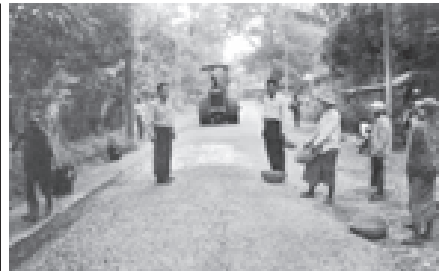
ဝမ်းကွင်းမြို့နယ် စည်ပင်သာယာရေးအဖွဲ့က ဆောင်ရွက်လျက်ရှိသော မြေပြောက်ဘက်လမ်း ကျောက်ချောလမ်း ခင်းခြင်းလုပ်ငန်းကို လက်ထောက်အင်ဂျင်နီယာ ဦးဖိုးမင်းသန့်နှင့် အငယ်တန်း အင်ဂျင်နီယာ(၂) ဦးမောင်မောင်ကျော်တို့ ကြီးကြပ်ဆောင်ရွက်စဉ်။ (မြို့နယ်စည်ပင်)
