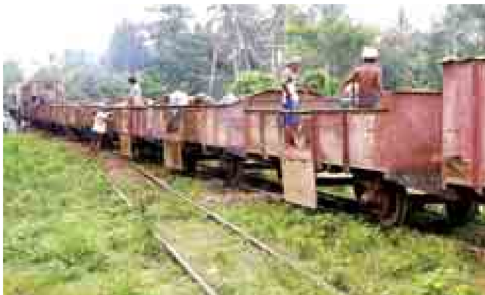
သက်တမ်းကြာမြင့်ပြီဖြစ်သည့် ရန်ကုန်-မန္တလေး အစုန်-အဆန်လမ်းပိုင်းအလိုက် ကြံ့ခိုင်မှုရှိစေရန် ကျောက်များ ပြည့်တင်းခြင်းလုပ်ငန်းများဆောင်ရွက်လျက်ရှိသည်ကို အောက်တိုဘာ ၆ ရက် နံနက်ပိုင်းက ရေတာရှည်မြို့နယ် ဆွာမြို့အဝင်တွင် မြင်တွေ့ရစဉ်။ (၅၇၈)
