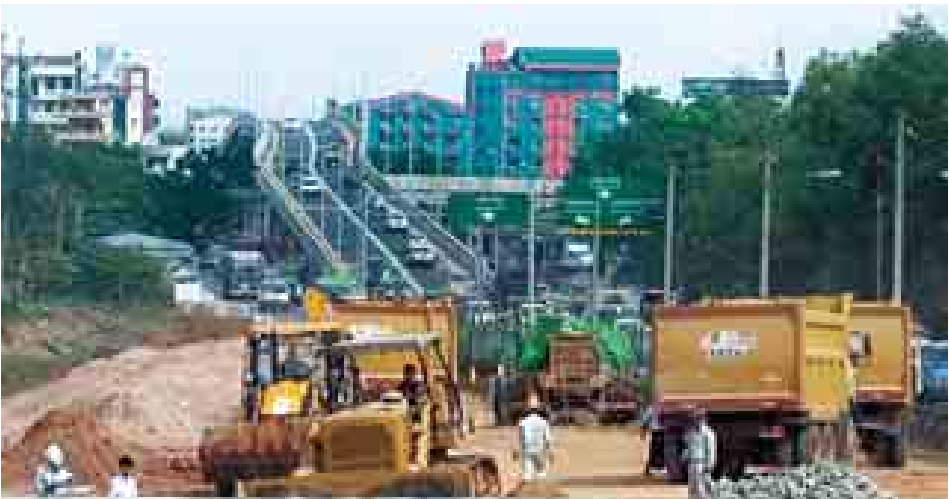
ဘုရင့်နောင်တံတား အမှတ်(၂) တည်ဆောက်ရေးလုပ်ငန်းများ ဆောင်ရွက်နေမှုကို တွေ့ရစဉ်။
