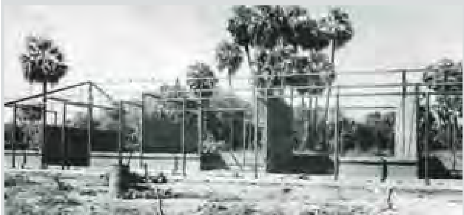
အောင်ချမ်းစည် မူလတန်းကျောင်းဆောင် ဆောက်လုပ်မှုကို တွေ့ရစဉ်။
