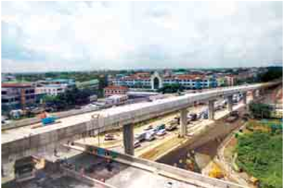
မရမ်းကုန်းမြို့နယ်၌ တည်ဆောက်နေသော ဘုရင့်နောင်လမ်းဆုံ ခုံးကျော်တံတားစီမံကိန်း၏ တတိယအလွှာခင်းကျင်းနေမှုကို တွေ့ရစဉ်။ (သတင်း-ရှေ့ဖူး)
