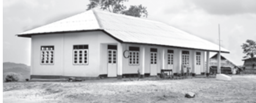
ကျကုနီကျေးရွာ အခြေခံပညာ မူလတန်းကျောင်း တည်ဆောက်ပြီးစီးမှုကို တွေ့ရရည်။
