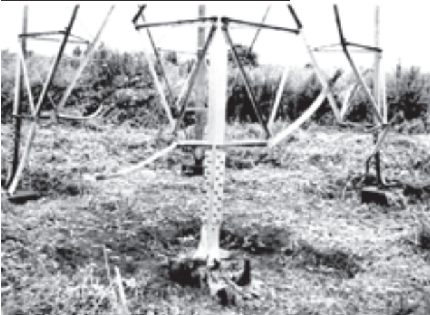
သောင်းကျန်းသူများ မိုင်းထောင်ဖောက်ခွဲပျက်ဆီးမှုကြောင့် ၂၃၀ ကေစီ ရွှေလီ-မန်စံ မဟာဓာတ်အား လိုင်း၏ တာဝါတိုင် အမှတ် (၃၀၅) အောက်ခြေတိုင်များ ချိုယွင်းပျက်စီးမှုကို တွေ့ရစဉ်။ (သတင်းစဉ်)
