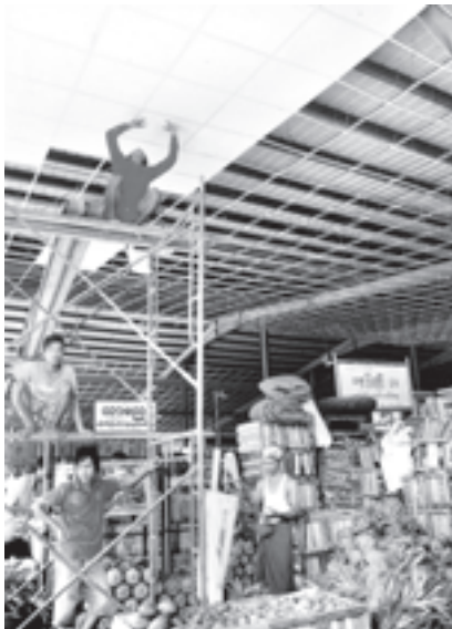
သီရိမင်္ဂလာဈေးရုံကြီး (ခ) နှင့် မျက်နှာကြက်အစိုး ကျောက်ပြား တပ်ဆင်နေစဉ်။
