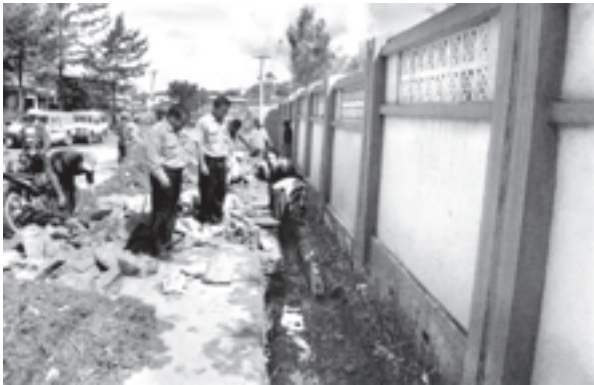
ဟားခါးမြို့နယ် ပြည်နယ်အစိုးရရုံးရှေ့ ကျောက်စီရေမြောင်းလုပ်ငန်းကို ဩဂုတ် ၂ ရက်က အမှုဆောင်အရာရှိ ဦးတစ်ဆောင်နှင့် လက်ထောက်အင်ဂျင်နီယာ ဦးလန်းနိုင်တို့ ကြီးကြပ်ဆောင်ရွက်ကြစဉ်။ (မြို့နယ်စည်ပင်)
