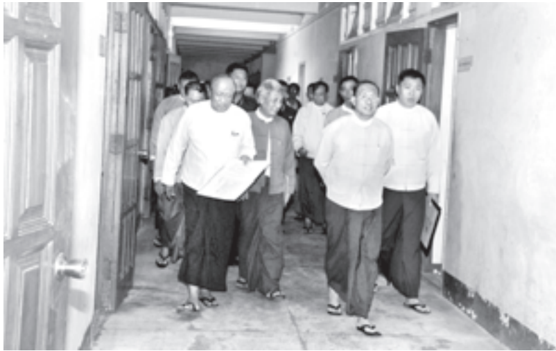
ဒုတိယသမ္မတ သီဟသူရဦးတင်အောင်မြင်ဦး ရန်ကုန်မြို့၊ ပြည်လမ်းရှိ စွမ်းအင်ဝန်ကြီးဌာန(ရန်ကုန်ရုံးခန်း)အား ဆေးရုံအဖြစ် ပြုပြင်မွမ်းမံ တည်ဆောက်မည့် အဆောက်အအုံများ ပြုပြင်ဆောင်ရွက်မှုကို ကြည့်ရှု စစ်ဆေးစဉ်။
