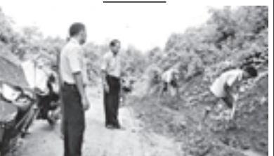
ရမ်းဗြဲမြို့နယ် စည်ပင်သာယာရေးအဖွဲ့က ရမ်းဗြဲ-ကျောက်နီမော်လမ်းဘေး ရေမြောင်းများ တူးဖော်ရှင်းလင်းနေမှုကို ဩဂုတ် ၃ ရက်က အမှုဆောင်အရာရှိ ဦးထွန်းခင် ကြီးကြပ်ဆောင်ရွက်စဉ်။ (မြို့နယ်စည်ပင်)
