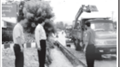
ကျိုင်းတုံမြို့နယ် စည်ပင်သာယာရေးအဖွဲ့က မြို့သန့်ရှင်းသာယာလှပရေး နှင့်ရေစီးရေလာကောင်းမွန်ရေးအတွက် တောင်ကြီးလမ်းဘေး ရေမြောင်းတူးဖော် နေမှုကို မြို့တွင် ၂ ရက်ကအမှုဆောင်အရာရှိ ဦးကျော်စိုးထွန်းနှင့် တာဝန်ခံ အင်ဂျင်နီယာဦးမျိုးမင်းသန့်တို့ ကြည့်ရှုဆောင်ရွက်ကြစဉ်။ (မြို့နယ်စည်ပင်)
