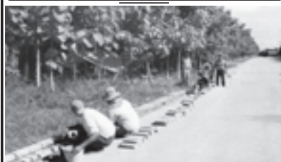
တာချီလိတ်မြို့နယ် စည်ပင်သာယာရေးအဖွဲ့က မြို့သန့်ရှင်းသာယာလှပရေး အတွက် ကျိုင်းတုံမြို့အတွက် လမ်းဘေးဝဲယာ ကပ်တုံးများပြုလုပ်ခြင်းကို ဇူလိုင် ၃၀ ရက်က အမှောင်အနောဂျီ ဦးကျိန်နှင့် လက်ထောက်အင်ဂျင်နီယာ ဦးတင်ဝမ်းမောင်တို့ ကြီးကြပ်ဆောင်ရွက်ကြစဉ်။ (၀၆၀)
