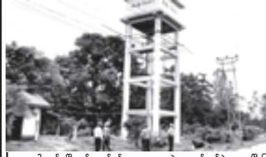
ဝါဒကုန်းမြို့နယ် စည်ပင်သာယာရေးအဖွဲ့မှဆောင်ရွက်ခဲ့သော မြို့ပြရေပေးရေးလုပ်ငန်းဖြစ်သည့် ဂါလန် ၆၀၀၀သံ သံကွက်ကန်ရစ်ရေစင်ဆောင်ရွက်ပြီးစီးမှုကို ဇူလိုင် ၂၁ ရက်က အမှောင်အရာရှိ ဦးကျော်နိုင်နှင့် လက်ထောက်အင်ဂျင်နီယာ ဦးကျော်မျိုးအောင်တို့ ကွင်းဆင်းစစ်ဆေးရာ အထောက်အကူပြုသူ ဦးကျော်နိုင်နှင့် ဦးကျော်မျိုးအောင်တို့ ရှင်းလင်းတင်ပြစဉ်။
