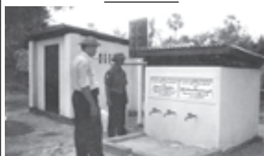
ဒီပဲယင်းမြို့နယ် အင်္ဂတီအုပ်စု ဝန်းရံကျေးရွာအတွက် စက်ရေကွင်း အလှူရှင်များလှူဒါန်းသော စက်ရေကွင်း ရေကန်ကို ရေကန်အောက်လုပ်ငြိမ်းမှုကို စုစုံပေါင်း ၅ ရက်က အမှူးဆောင်အရာရှိ ဦးကျော်လင်းနှင့် တာဝန်ခံအရာရှိ ဦးမောင်လင်းတို့ စစ်ဆေးကြစဉ်။ (မြို့နယ် မြန်မာ့)
