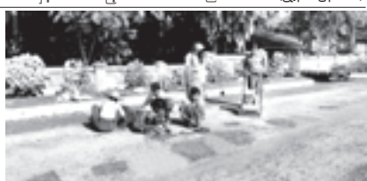
ဇူလိုင် ၃ ရက်က စစ်တွေမြို့နယ် လမ်းမကြီးပြင်ခြင်းလုပ်ငန်းကို လက်ထောက်အင်ဂျင်နီယာ ခေါင်ခင်ဆွေးအောင်နှင့် ဝန်ထမ်းများ စုပေါင်းဆောင်ရွက်ကြသည်။ (မြို့နယ်အသင်း)
