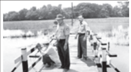
လေးမျက်နှာမြို့နယ် စည်ပင်သာယာရေးအဖွဲ့မှ ညောင်ပင်လွင်သွားလမ်း သစ်သားတံတားတည်ဆောက်နေမှုကို ဇွန် ၁၇ ရက်က အမှုဆောင်အရာရှိ ဦးဌေးလွင်နှင့် အထိမ်းအမှတ်အင်ဂျင်နီယာ(၂) ဦးမျိုးချစ်ဦးတို့ ကြီးကြပ်ဆောင်ရွက်ကြစဉ်။ (မြို့နယ်စည်ပင်)
