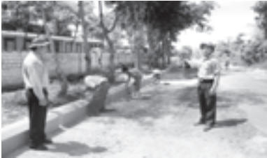
ဖယ်နဲမြို့နယ် စစ်တွန်းလမ်း ပလက်မောင်းကတ်တုံးများ ပြုလုပ်နေမှု ကို မေ ၂၀ ရက်က မြို့နယ်အမှုဆောင်အရာရှိ ဦးကျော်မင်းထိုက်နှင့် တာဝန်ခံအင်ဂျင်နီယာ ဦးစောမင်းထွန်းတို့ ကြီးကြပ်ဆောင်ရွက်စဉ်။ (မြို့နယ်စည်ပင်)
