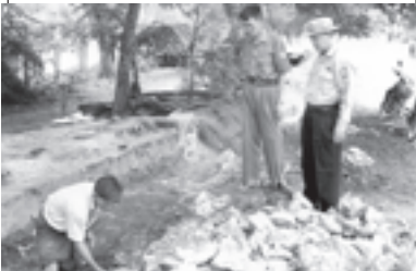
ဆီဖိုင်မြို့နယ် အင်ကြင်းလမ်း ကွန်ကရစ်လမ်းခင်းခြင်းလုပ်ငန်းကို မေ ၃၀ ရက်က အမှုဆောင်အရာရှိ ဦးသိန်းမင်း ကြီးကြပ်ဆောင်ရွက် စဉ်။ (မြို့နယ်စည်ပင်)
