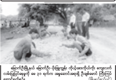
မြောက်ဦးမြို့နယ် မြောက်ဦး-မိုးမြို့ကျွန်း ကိုယ်အားကိုးကိုး ကျေးလက်လမ်းပြုပြင်မှုကို မေ ၃၁ ရက်က အမှုဆောင်အရာရှိ ဦးအောင်မြင့် ကြီးကြပ်ဆောင်ရွက်ခဲ့သည်။ (မြို့နယ်စည်ပင်)
