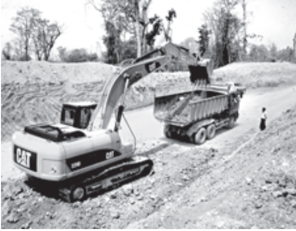
စင်းခန်း-ကသာ ၆၅ မိုင်ကားလမ်းသစ်ဖောက်လုပ်ရေးလုပ်ငန်းတွင် စက်ကြီးများဖြင့် မြေသားလုပ်ငန်းဆောင်ရွက်နေစဉ်။
