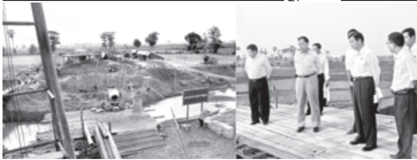
ရထားပို့ဆောင်ရေးဝန်ကြီးဌာန ပြည်ထောင်စုဝန်ကြီး ဦးအောင်မင်း တပ်ကုန်းမြို့နယ် ဖျိုင်းအင်းကျေးရွာအနီးရှိ နဝင်းချောင်းတံတား တည်ဆောက်နေမှုကို ကြည့်ရှုစစ်ဆေးစဉ်။ (သတင်းစဉ်)
