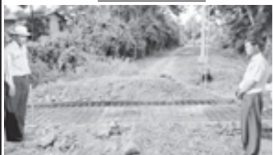
မအူပင်မြို့နယ် အမှတ် (၁)ရပ်ကွက် ရေစက်လောင်းခန်းရှိ မြောင်းကူးတံတား ကွန်ကရစ်လောင်းခြင်းလုပ်ငန်းကို ဧပြီ ၁၅ရက်က အမှဆောင်အရာရှိ ဦးအောင်ကျော်စိုးနှင့် တာဝန်ခံအင်ဂျင်နီယာ ဦးအောင်ကျော်စိုးတို့ ကြုံကြည့်ဆောင်ရွက်စဉ်။ (မြို့နယ်စည်ပင်)
