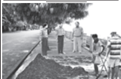
မော်လမြိုင်မြို့ ကမ်းနားလမ်း သာယာလှပရေးအတွက် ပလက်မောင်း ဖြည့်ဖြန်းလုပ်ငန်းကို ဧပြီ ၂၃ ရက်က အမှဆောင်အရာရှိ ဦးတင်ဝင်း ကြုံကြည့်ဆောင်ရွက်စဉ်။ (၁၀၇)
