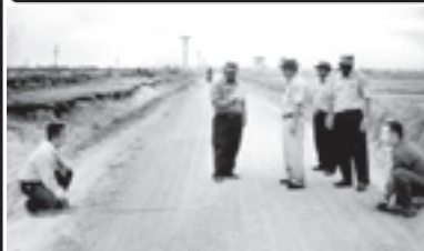
မိုးဦးစည်ပင် အင်ကြင်းကုန်း-ညောင်ကုန်းကျေးရွာချင်းဆက်လမ်းသို့ ကျောက်ခင်းခြင်းလုပ်ငန်းဆောင်ရွက်ထားရှိမှုကို ဧပြီ ၇ ရက်က ကချင်ပြည်နယ် စည်ပင်သာယာရေးအဖွဲ့ ညွှန်ကြားရေးမှူး ဦးအောင်နှင့်အဖွဲ့၊ ကွင်းဆင်းစစ်ဆေးရာ အမှုဆောင်အရာရှိ ဦးအောင်နှင့် ရှင်းလင်းတင်ပြစဉ်။ (မြို့နယ်စည်ပင်)
