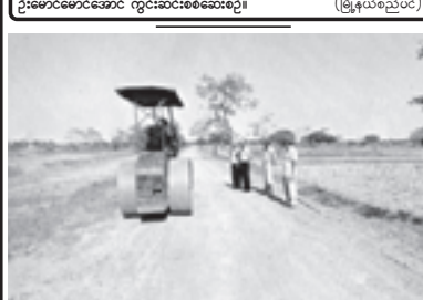
ဧကန်မြို့နယ် ပျဉ်းမကုန်းရုံးစုကျေးလက်လမ်း ကျောက်ချောင်းခြင်းလုပ်ငန်းဆောင်ရွက်နေမှုကို ဧပြီ ၇ ရက်က စတုရန်းတိုင်းဒေသကြီး စည်ပင်သာယာရေးအဖွဲ့ ညွှန်ကြားရေးမှူး ဦးအောင်မင်းနိုင်နှင့် အင်ဂျင်နီယာမှူးကြီး ဦးနီသန်းတို့ ကွင်းဆင်းစစ်ဆေးစဉ်။ (မြို့နယ်စည်ပင်)
