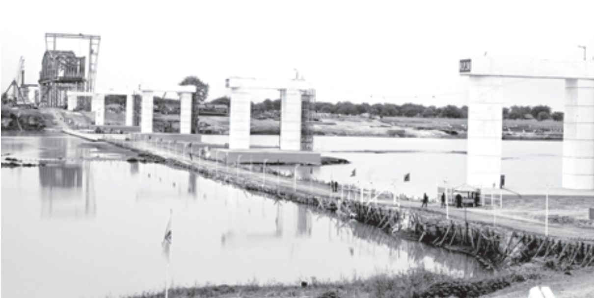
ဧရာဝတီတံတား(ပခုက္ကူ) ပခုက္ကူဘက်ကမ်း တံတားတည်ဆောက်နေမှုကို တွေ့ရစဉ်။
