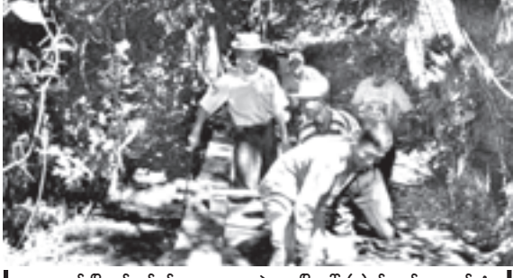
ဖလမ်းမြို့နယ်စည်ပင်သာယာရေးအဖွဲ့က မြို့ပေါ် (၄)ရပ်ကွက် သောက်သုံးရေရရှိရေးအတွက် မြို့မှ ၁၂မိုင် ၆ ဖာလုံအကွာတွင် တည်ရှိသော တလန်လင်း စိမ့်စမ်းရေထွက်မှု ပင်မပိုက်လိုင်းများ ပြုပြင်ခြင်းကို မတ် ၅ရက်က အမှုဆောင်အရာရှိ ဦးထလာဟရဲ ကြီးကြပ်ဆောင်ရွက်စဉ်။ (ခရိုင် ပြန်/ဆက်)
