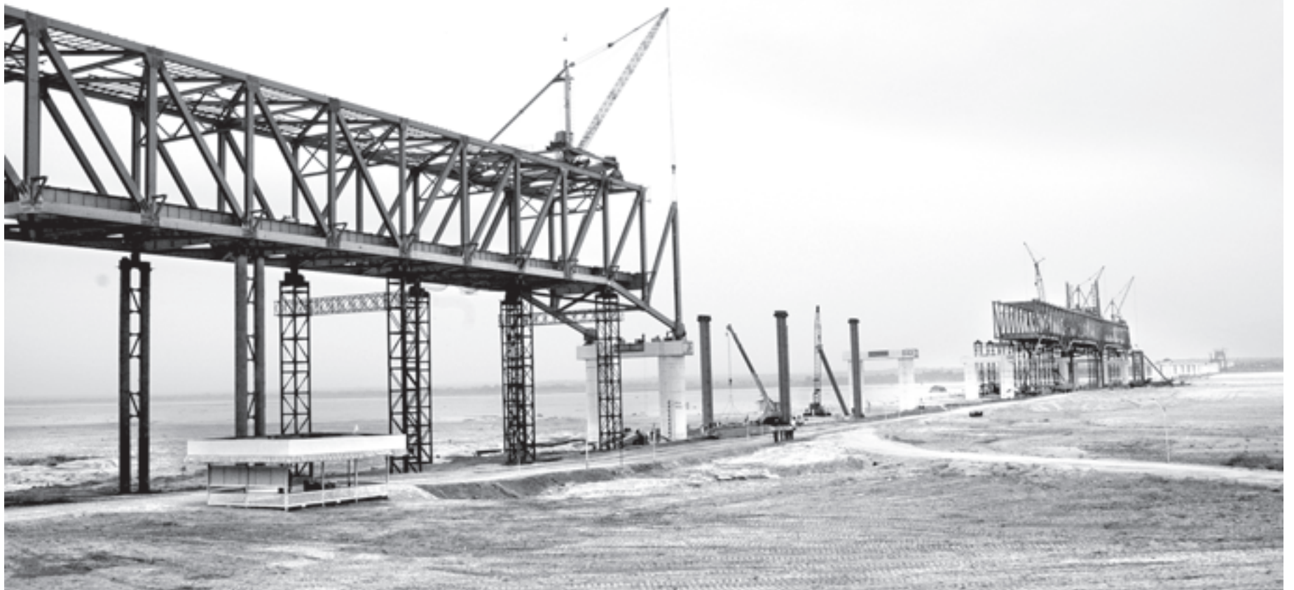
ဧရာဝတီတံတား(ပခုက္ကူ) တံတားတည်ဆောက်နေမှုကို တွေ့ရစဉ်။ (သတင်းစဉ်)
