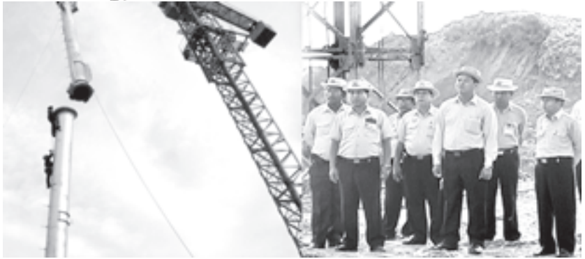
အမှတ်(၂) လျှပ်စစ်ဓွမ်းအားဝန်ကြီးဌာန ဒုတိယဝန်ကြီး ဦးအောင်သန်းဦး လိုင်သာယာ-အလုံ မဟာ ဓာတ်အားလှိုင်း (လိုင်မြစ်ကျော်) တည်ဆောက်ရေးစီမံကိန်းတွင် ကြည့်ရှုစစ်ဆေးစဉ်။ (သတင်းစဉ်)
