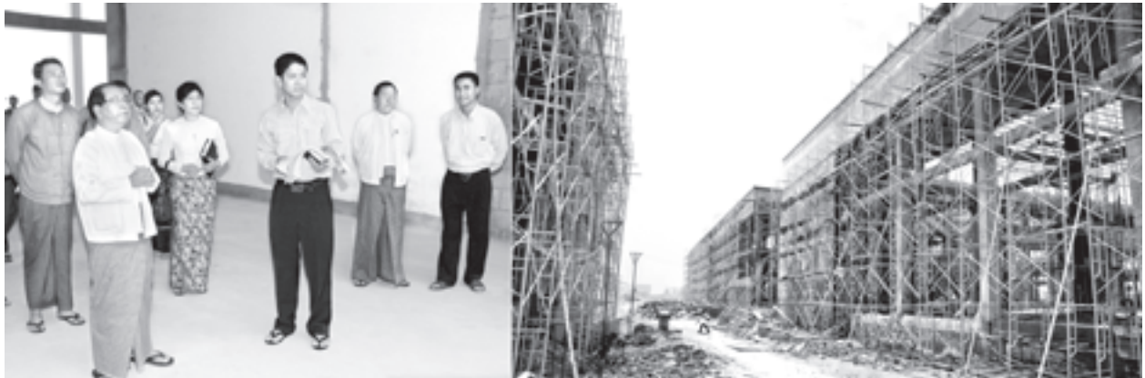
မြန်မာ့ရေးဝန်ကြီးဌာနနှင့် ယဉ်ကျေးမှုဝန်ကြီးဌာန ဝန်ကြီး ဦးကျော်ဆန်း အမျိုးသားပြတိုက်(နေပြည်တော်) တည်ဆောက်နေမှုအခြေအနေများကို ကြည့်ရှုစစ်ဆေးစဉ်။ (သတင်းစဉ်)
