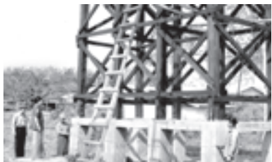
ကောလင်းမြို့၊ ငမ္ပေးကြီးရပ်ကွက် ရေပေးရေးအတွက် ၂၆ ပေအမြင့် ရေစင်နှင့် ဂါလန် ၃၂၀၀ ဆုံ သံရေကန်တည်ဆောက်ပြီးစီးနေမှုကို စေတနာပါရီ ၁၈ ရက်က မြို့နယ်စည်ပင်သာယာရေးအဖွဲ့ အမှုဆောင်အရာရှိ ဦးတင့်စေ ကွင်းဆင်း ကြည့်ရှုစစ်ဆေးစဉ်။ (၀၉၂)
