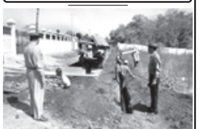
တောင်ကြီးမြို့နယ် စည်ပင်သာယာရေးအဖွဲ့မှ ရပ်ကွက်များအတွင်း ရေလှောင်ကန်များ တည်ဆောက်သည့်အတွက် ဧပြီ ၅ ရက်က အမှုဆောင်အရာရှိနှင့် အင်ဂျင်နီယာများကြီး ကြီးကြပ်ဆောင်ရွက်စဉ်။ (မြို့နယ်စည်ပင်)
