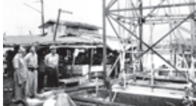
ဖျာပုံမြို့နယ် မြို့မနေ့ကြီးအတွင်း ဂါလန် ၁၆၀၀ဆုံ သံရေစက်ဆောက်လုပ် ခြင်းလုပ်ငန်းကို မတ် ၁၈ ရက်က ဧရာဝတီတိုင်းဒေသကြီး စည်ပင်သာယာရေး အဖွဲ့၊ ညွှန်ကြားရေးမှူး ကြည့်ရှုစစ်ဆေးစဉ်။ (၀၆၆)
