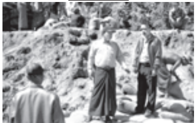
ရွာကုမ္ပဏီက ဘုန်းမရွာစု၊ မြေသားတစ်ခုနှင့် ရေတံခါးတည်ဆောက်ခြင်း လုပ်ငန်းကို မတ် ၁၄ ရက်က မြို့နယ်အုပ်ချုပ်ရေးမှူး ဦးညီညီနှင့်အဖွဲ့ ကြည့်ရှု စစ်ဆေးစဉ်။ (၀၉၃)
