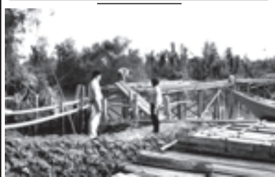
ပုသိမ်မြို့နယ် လေးမျက်နှာကျေးရွာ ဆိပ်ကြီးချောင်းကား ကွန်ကရစ်တံတား ဆောက်လုပ်ခြင်းလုပ်ငန်းကို ဧပြီ ၈ ရက်က မြို့နယ်စည်ပင်သာယာရေးအဖွဲ့ အမှုဆောင်အရာရှိ ဦးနေထက်ရှိန်နှင့် တာဝန်ခံအင်ဂျင်နီယာ ဦးစတင်ဝေတို့ ကြီးကြပ်ဆောင်ရွက်စဉ်။ (မြို့နယ်စည်ပင်)
