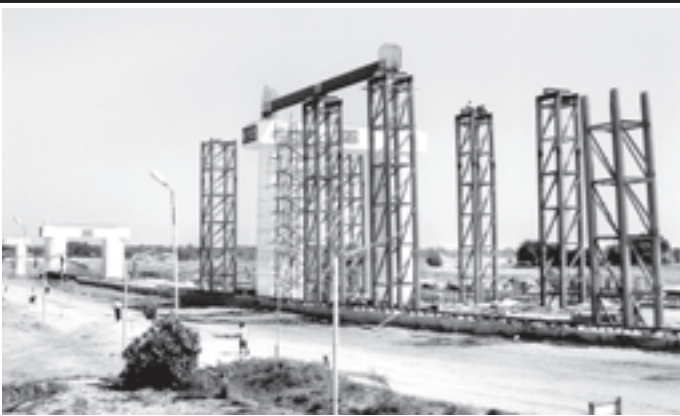
ကျွန်းတော်ဆောက်လုပ်ရေးစီမံကိန်း ပခုက္ကူဘက်ကမ်း ရေလယ်ကျွန်းတွင် သံပေါင်များ တည်ဆောက်နေခြင်းကို ဤသို့ တွေ့ရသည်။
