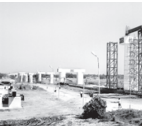
ဧရာဝတီတံတား(ပခုက္ကူ)တည်ဆောက်ရေးစီမံကိန်း ပခုက္ကူဘက်ကမ်း ရေလယ် တောင်တစ်ဆင့်ထားသည့်ကို ဤသို့ တွေ့ခဲ့ရသည်။
