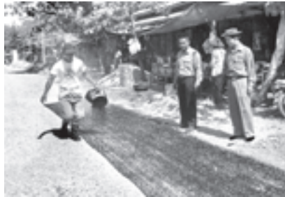
ဧပြီ ၅ ရက်က ရမည်းသင်းမြို့နယ် စည်ပင်သာယာရေးအဖွဲ့မှ လက်ထောက်အင်ဂျင်နီယာ ဦးအောင်ပြည့်၊ ဦးမင်းနိုင်နှင့်အဖွဲ့ လမ်း ကမ္ဘာ့ရာဇဝင်မြင်းလုပ်ငန်း ဆောင်ရွက်ကြစဉ်။ (သတင်းစဉ်)
